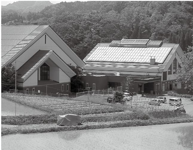
改修の必要性が見込まれるびっくらんど小川
