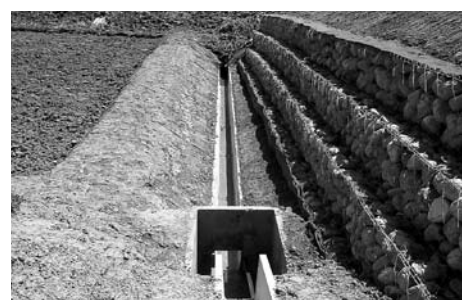
復旧された水田・水路(塩沢)
