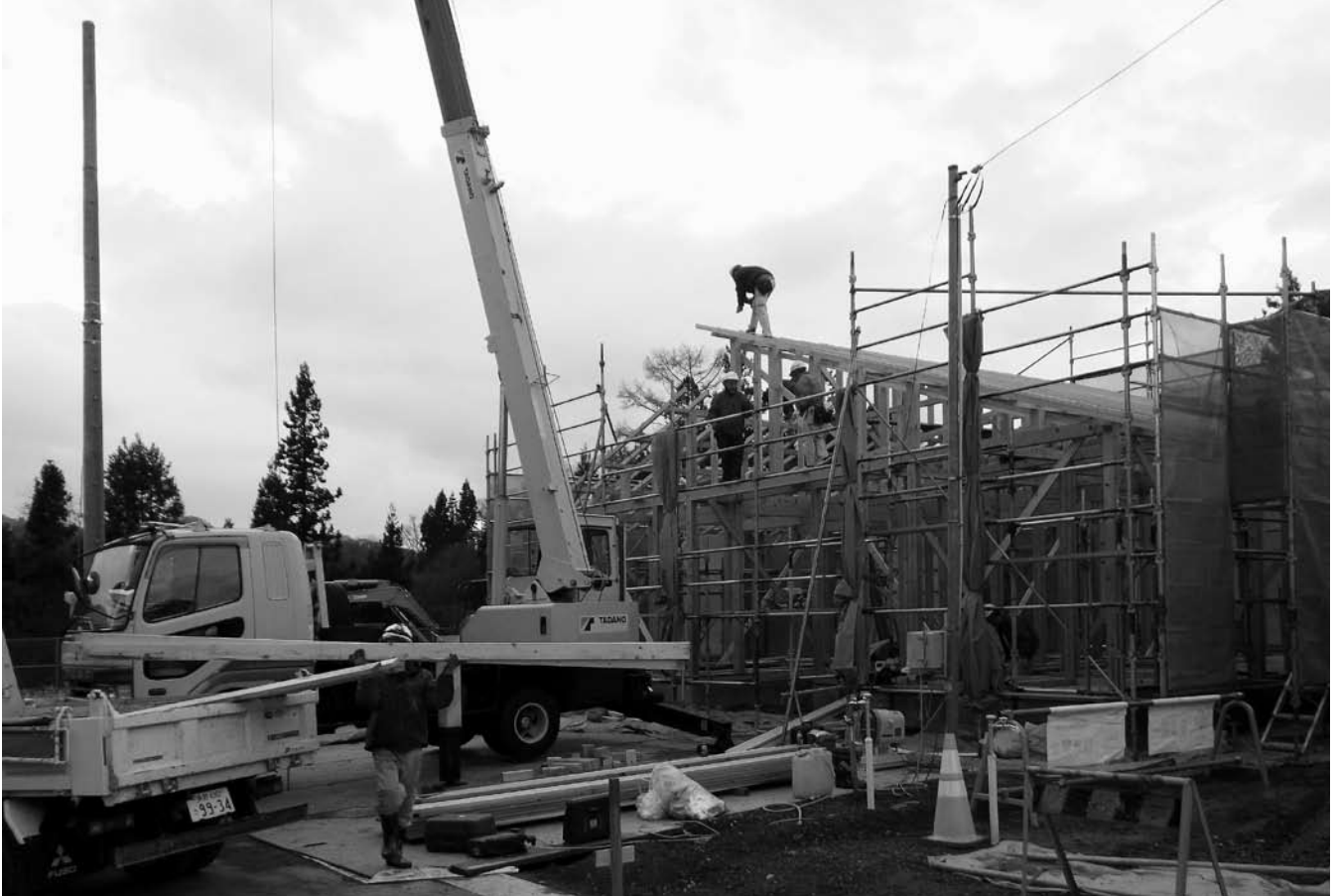
建設が進む若者定住促進住宅(鶴牧田)
