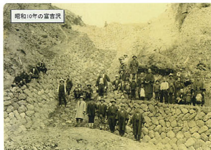
最前列の左から工事監督員、工事責任者、右4人が当時の砂防代
