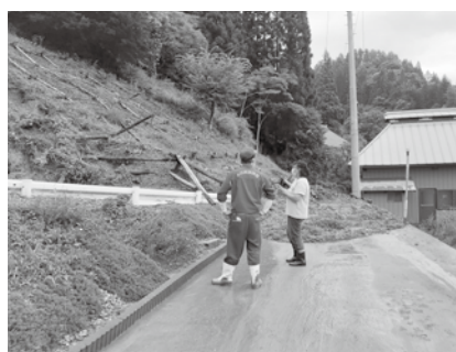
消防団による被災現場確認
