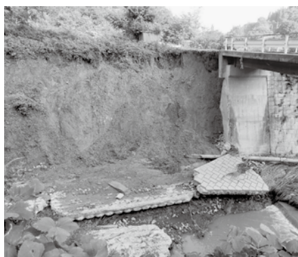
村道 1-1 号線（細越橋）
