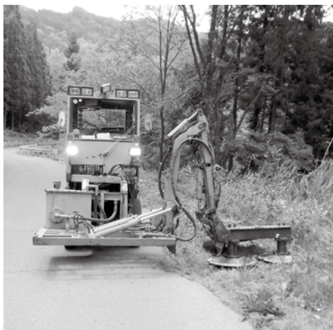
村道幹線道路草刈り作業中
