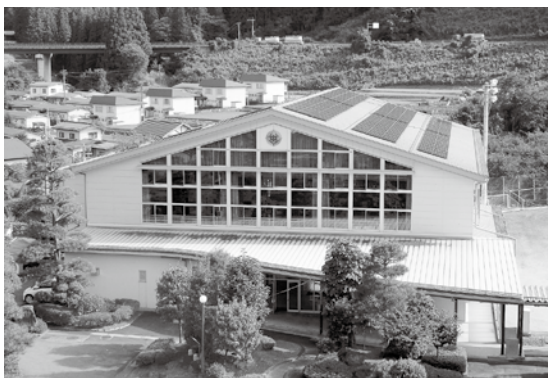
中学校体育館屋根の太陽光パネル
