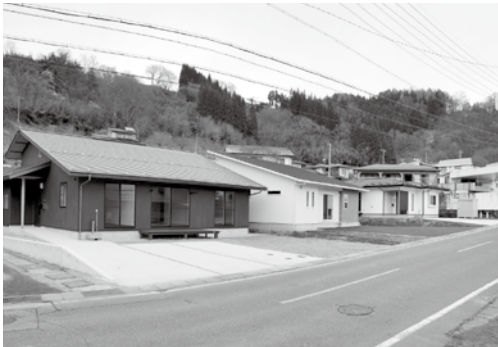
完成した新大久保団地
