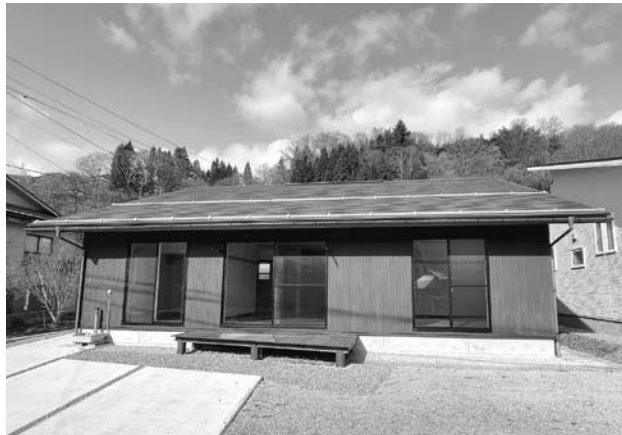
◀ 大久保に建設された村営住宅
