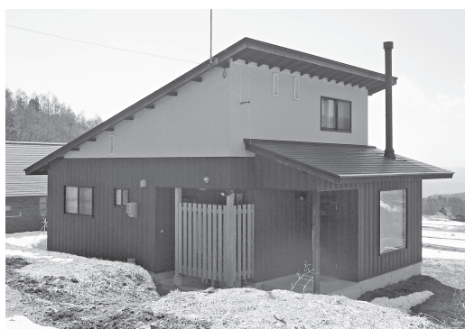
大洞地区にある移住体験宿泊施設
