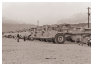
第二工区 資材運搬 1957年12月大型ダンプロック (現在、大町市民文化会館)
