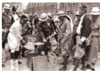
第一工区 ダム建設 1958年9月ダム定礎式
