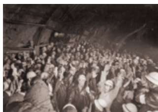
第四工区 掘削作業 1958年2月大町トンネル貫通 (現在、関電トンネル)
