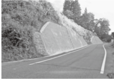
工事が進む村道16号線(第2工区)
