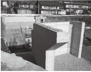
完成した大久保橋の橋台
