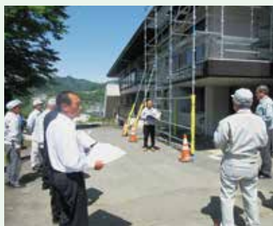
公民館工事状況の説明を受ける
